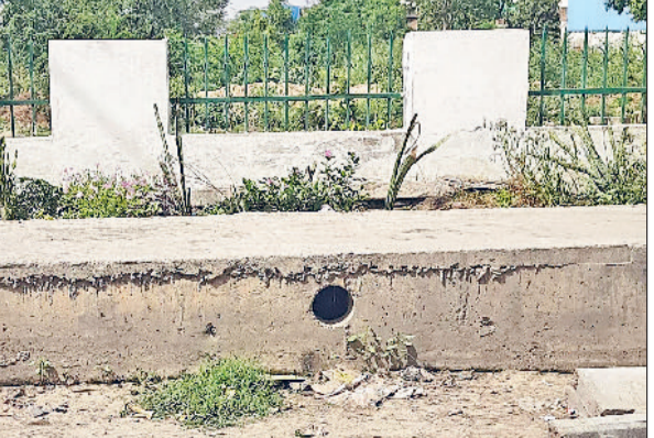
ऐसा प्रतीत होता है कि इनमें होल ओवरफ्लो होने पर नाले का पानी पानी जाने के लिए नहीं बल्कि बाहर निकालने के लिए बनाए गए हैं। इसी वजह से सड़कों पर जलभराव हो जाता है। इस तर्फ ध्यान देते हुए नालों की दशा में सुधार करना चाहिए।
