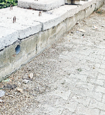
बहादुरगढ़। सब्जी मंडी के साथ लगते सड़क पर नाले में ऊंचाई पर बनाए गए होल तथा गोरेया साइट के पास नाले में सड़क की स्तह से ऊंचे बनाए गए होल।
